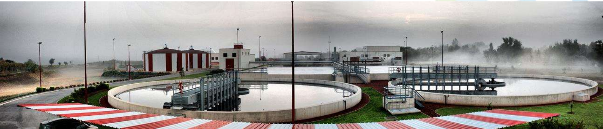
Calahorra WWTP, La Rioja
